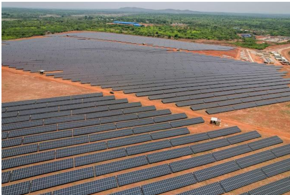
Photo 1 : Installation de la centrale photovoltaïque à Boundiali
